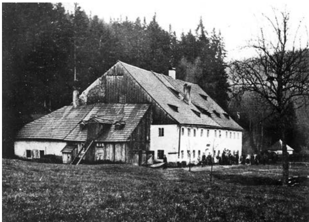
Obr. 6 Těžní budova úklonné jámy Eliáš, stav v 2. polovině 19. století. Foto archiv autorů.
