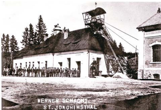
Obr. 9 Budova dolu Werner (dnes Rovnost I). Stav ve 20. letech 20. století. Foto archiv autorů.
