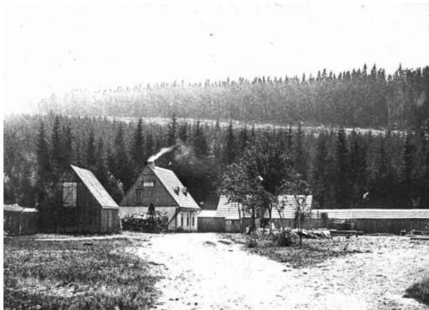
Obr. 7 Provozní budovy štoly Wassereinlass. Stav v 2. polovině 19. století. Foto archiv autorů.
