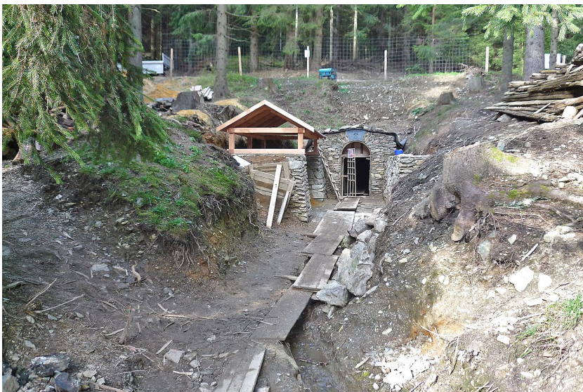
Obr. 3 Ústí štol Johannes; foto L. Vrtiška, říjen 2013.
