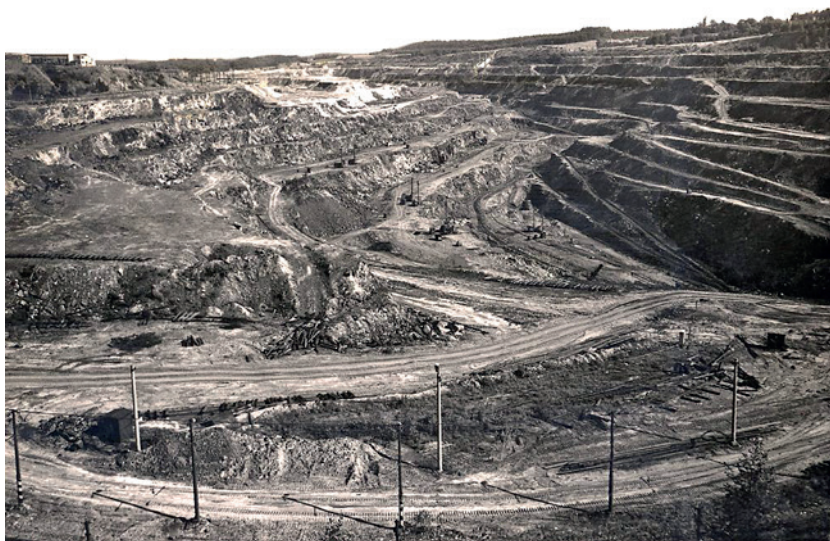
Obr. 1 Chvaletice, celkový pohled na povrchový důl (1973). Foto archiv autorů.
