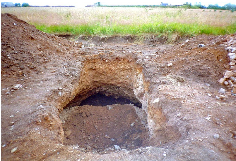
Obr. 1 Výstavba nové silnice na Cínovci, která přešla haldy po historickém dolování. Foto Z. Dvořák, 1999.
