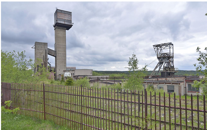
Obr. 19 Důl Měděnec - vlevo těžní věž skipojámy, vpravo starší klecová věž na dopravu mužstva. Foto M. Příbil 2012.
