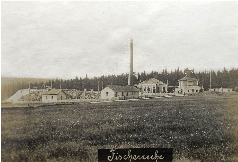
Obr. 17 Důl Fischer na pohlednici z počátku 20. století; zleva: halda, kotelna, elektrocentrála, strojevná těžního stroje, těžní věž.
