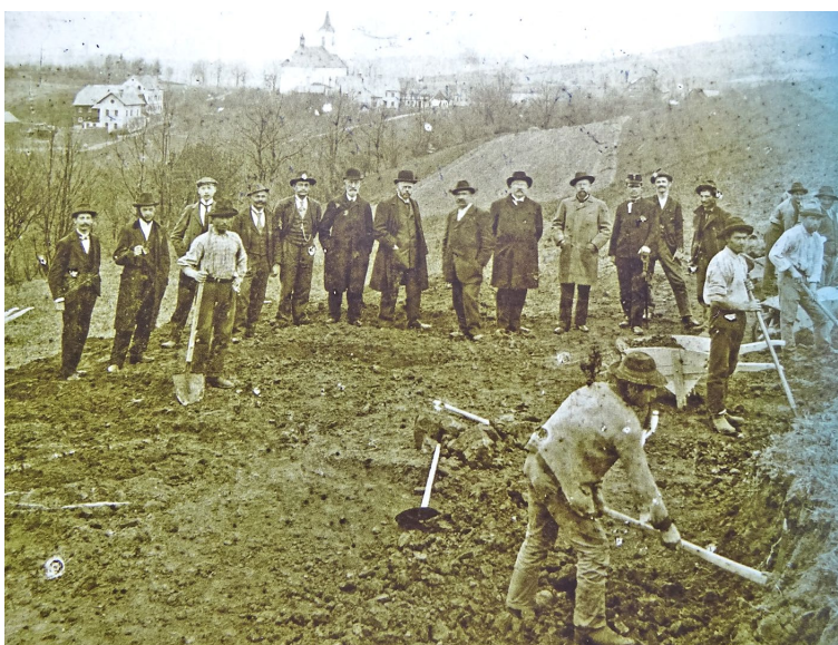
Obr. 4 Slavnostní výkop nově budované trati Kamenický Šenov-Česká Lípa ze dne 30. dubna 1902 v Mistrovicích (Kolektiv 2013).
