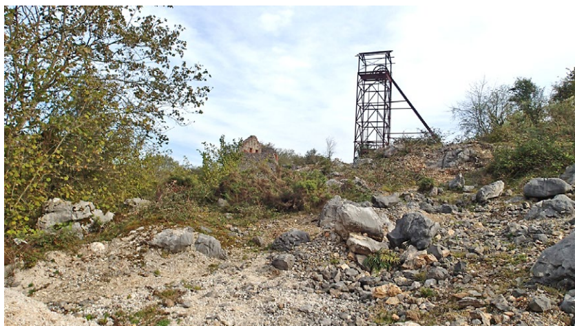
Obr. 2 Pozůstatky těžní věže dolu Mina Delfina, stav v říjnu 2015. Foto L. Vrtiška.
