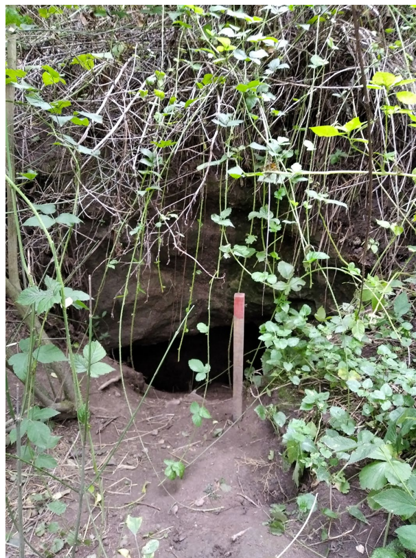
Obr. 2 Pohled na téměř zasypané ústí štoly sledující Cu zrudnění v Tismicích. Foto N. Profantová, stav v říjnu 2019.
